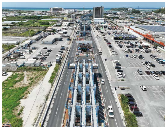
写真-1 那覇空港自動車道整備状況
