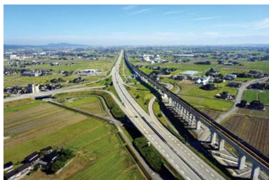
写真-4 能越道福岡IC付近（提供：国土交通省北陸地方整備局）
