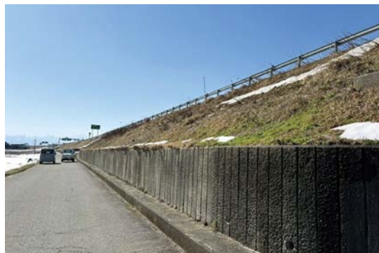
写真-3 縦スリット擁壁（提供：館敏幸氏（元建設省北陸地方建設局富山工事事務所調査第二課道路計画係主任））
