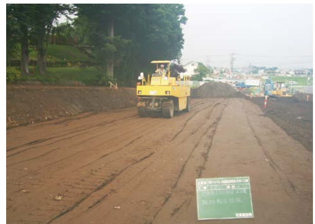
写真-1 日野バイパス工事状況
