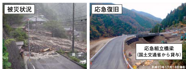
写真-2 応急組立橋による迂回路設置
