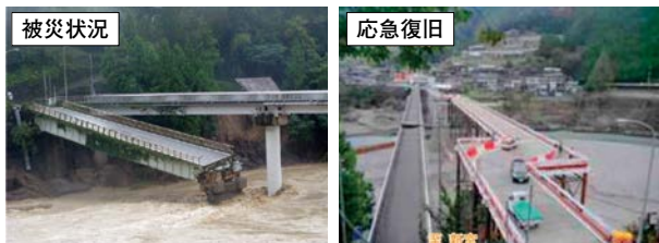
写真-3 折立橋の被災と迂回路の設置
