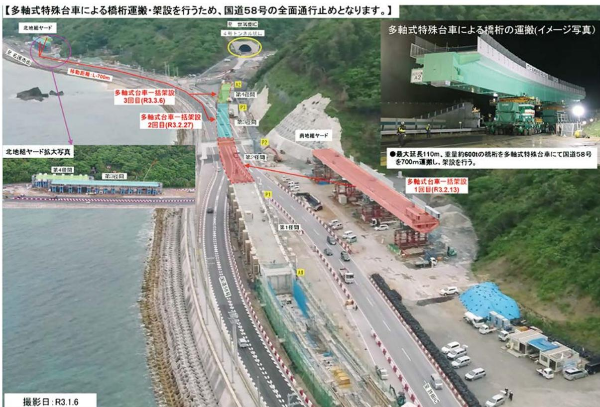
図-3 数久田IC オンランプ橋 工事概要
