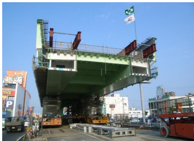
写真ー2 移動多軸台車に積み込まれた橋桁 (提供:国土交通省中国地方整備局)
