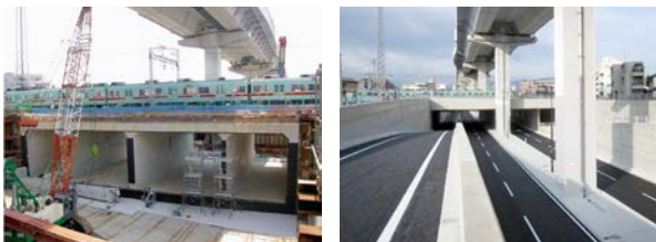
写真-1 1工区施工状況
