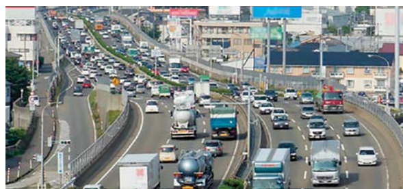
写真-2 12時間交通量が10万台を超え、保土ヶ谷バイパスとほぼ同じ交通量の新潟バイパス（出典：新潟国道事務所 3) ）
