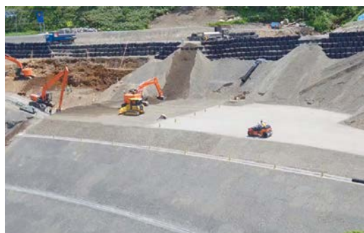
■ICT土工の施工状況
