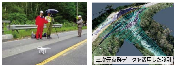
写真-2 被災状況の把握におけるUAV(ドローン)の活用
