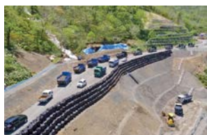
写真-6 工事車両混雑状況
