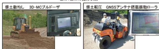
写真-8 ICT土工施工状況
