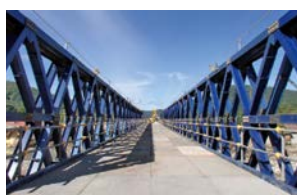
写真-5 千呂露橋仮橋架設状況
