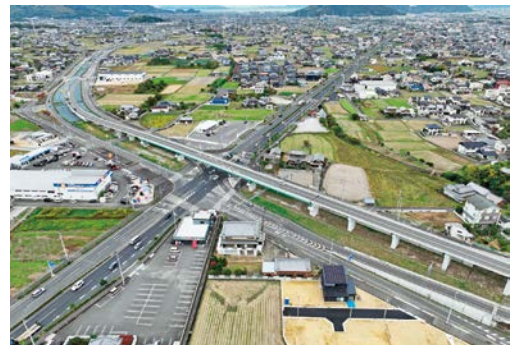
写真-1 中間工区・国道 32 号交差点部(令和 4 年 10 撮影。高架道路が空港連絡道路。右下が空港方面)
