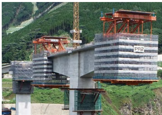
写真-3 超大型移動作業車による片持ち架設工法
