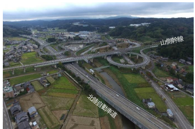
写真3 山側幹線の整備状況 (北陸自動車道と交差する金沢森本IC)
