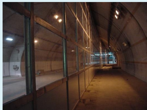
卯辰トンネルにおける歩車分離
