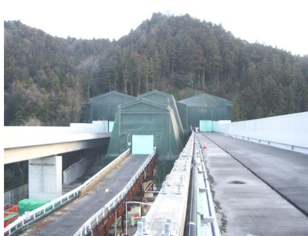
写真-4 トンネル坑口の防音扉
