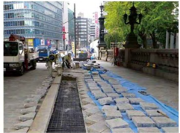
写真-5 舗石の撤去と復旧
