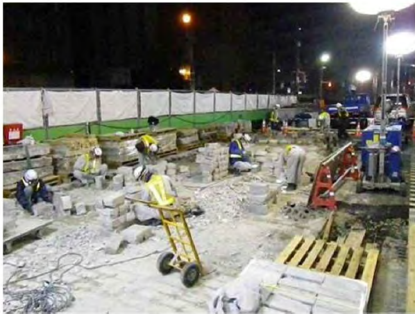
写真-5 舗石の撤去と復旧
