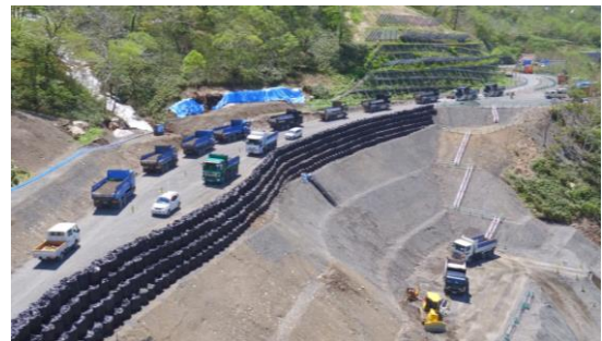
写真－7 工事車両混雑状況 (出典:国土交通省北海道開発局資料)
