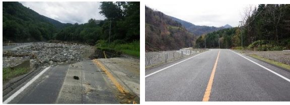
写真-8 擁壁のかさ上げ(千栄地区大規模欠損) (出典:国土交通省北海道開発局資料)
