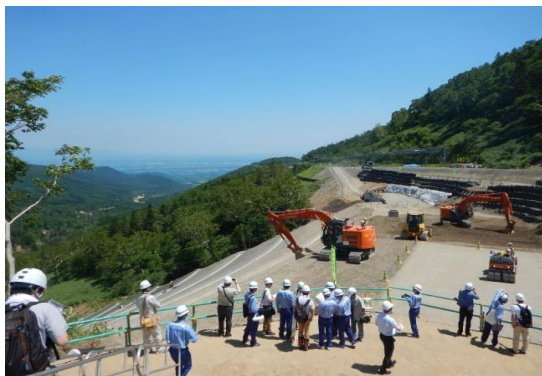
写真-15 報道機関を対象とした現地説明会 (復旧作業中) (出典:国土交通省北海道開発局資料)
