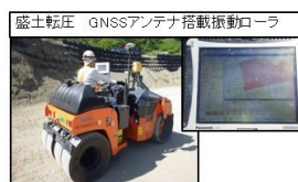
写真-9 ICT土工の活用(清水側7合目盛土崩壊) (出典:国土交通省北海道開発局資料)
