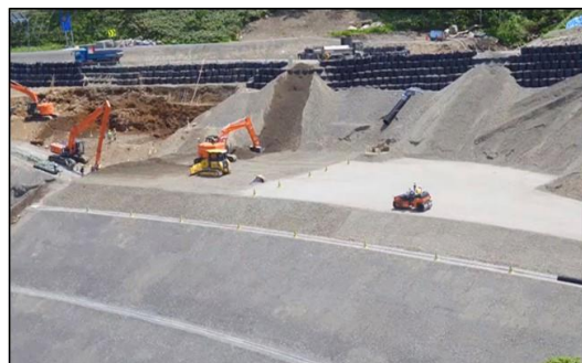
■ICT土工の施工状況
