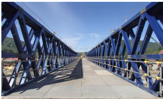
写真－5 千呂露橋仮橋架設状況 (出典:国土交通省北海道開発局資料)
