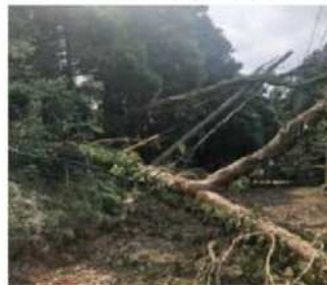
倒木による電柱倒壊(四街道市)
