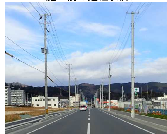
<施工前の建柱状況>
