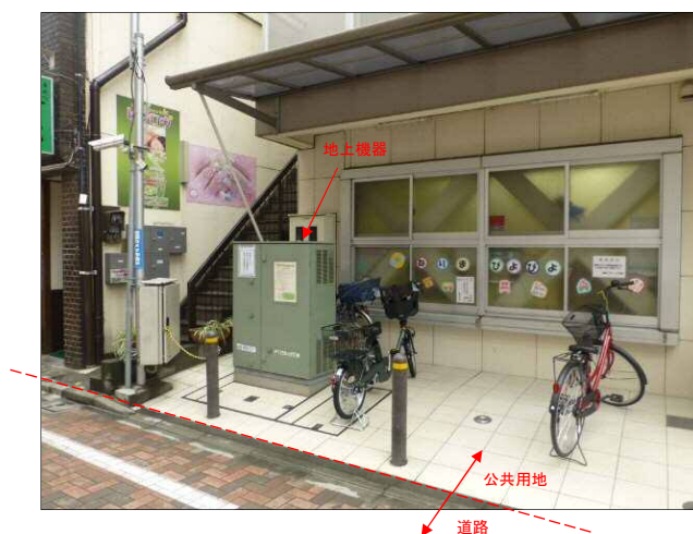
道路以外の活用事例（練馬区練馬駅南口）
