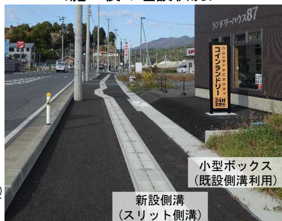
<施工後の埋設状況>
