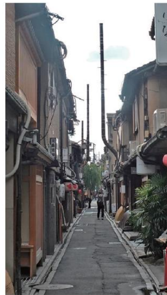
<ケーブル撤去後>
